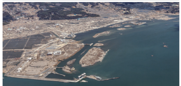
被災後 2011年3月撮影 Soon After the 3.11 Disaster March 2011
