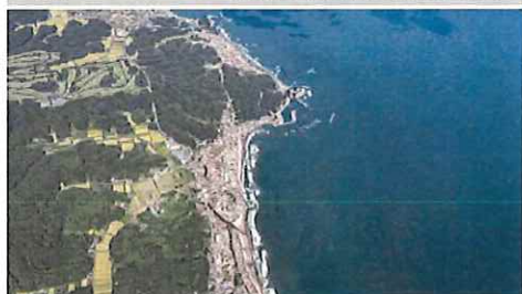
被災後 2011年9月撮影 Soon After the 3.11 Disaster September 2011
