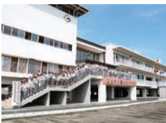
ピロティ方式（※）で再建された荒浜中学校
