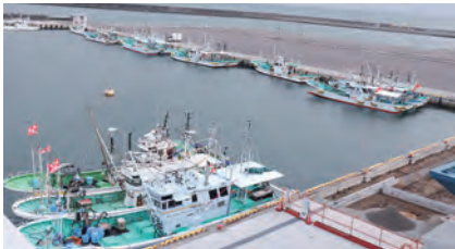
高度衛生管理を実現した荷さばき施設と請戸漁港
