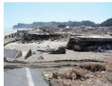
震災時の被災状況（薄磯地区）
