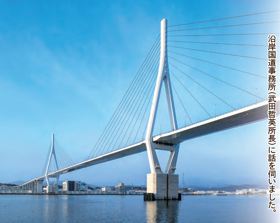
青空をバックに白の主塔や橋りょうなどが映える気仙沼湾横断橋
