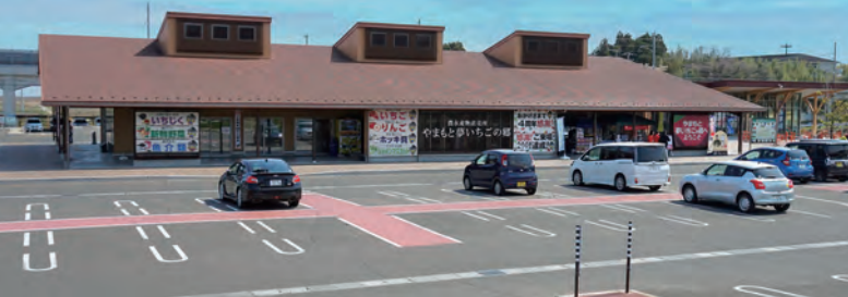
建物は木造平屋建て。2021年には新たにフードコートも整備した
