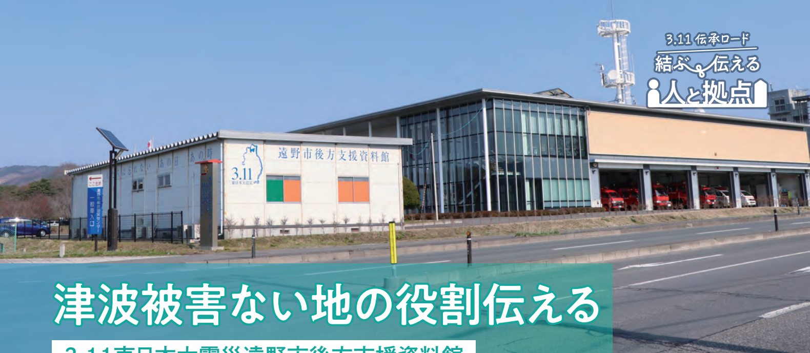
遠野市総合防災センターの駐車場一角にある3.11東日本大震災遠野市後方支援資料館
