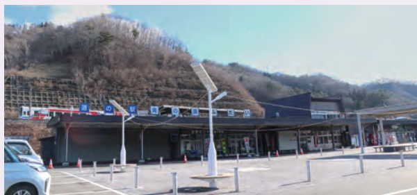
43台収容する駐車場や24時間利用できる屋外トイレなどを整備
