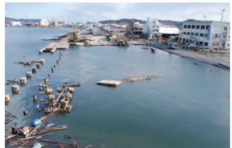
2011年3月23日、魚市場屋上から撮影した南側の被災した様子
