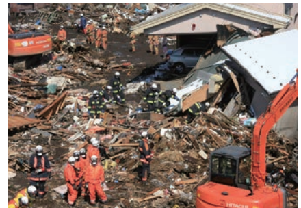
重機でがれきを除去しながらの捜索活動 (2011年3月17日)
