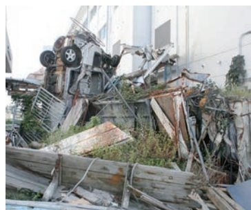
旧北校舎と総合実習棟を結ぶ渡り廊下があった場所に積み重なった車やがれき
