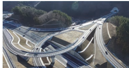
三陸道と釜石道が接続する釜石ジャンクション (写真提供:南三陸沿岸国道事務所)
