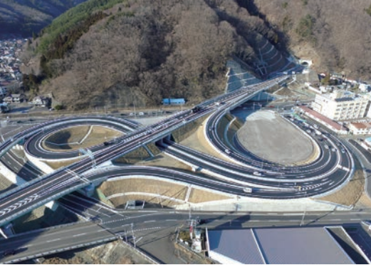
釜石市中心部に接続する釜石中央インターチェンジ (写真提供:南三陸沿岸国道事務所)
