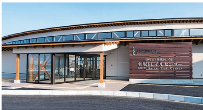
関上港近くにある名取トレイルセンターの外観
