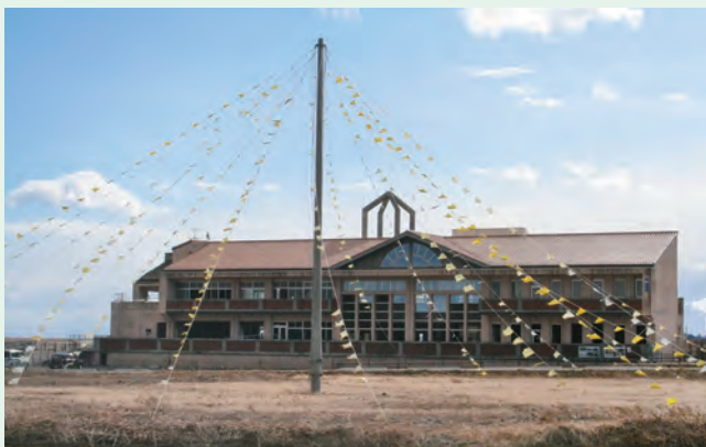
「山元町震災遺構 中浜小学校」の北側ではためく黄色いハンカチ
