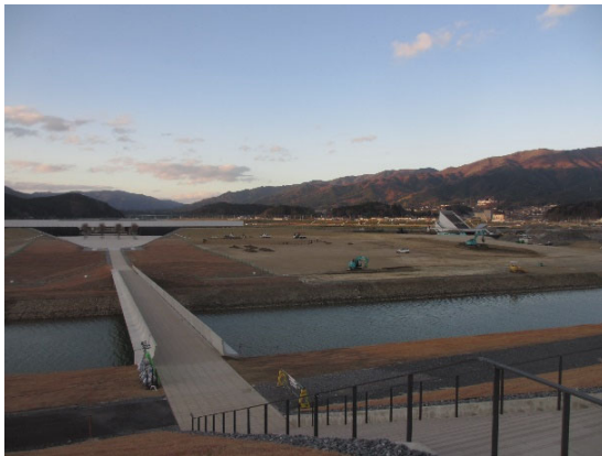
陸前高田市の祈念施設の堤防からの景色 東日本大震災津波伝承館と道の駅跡
