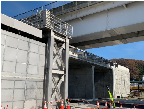
水門・陸こう自動閉鎖システムの導入
