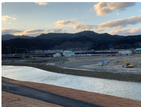
公園の整備進められています
