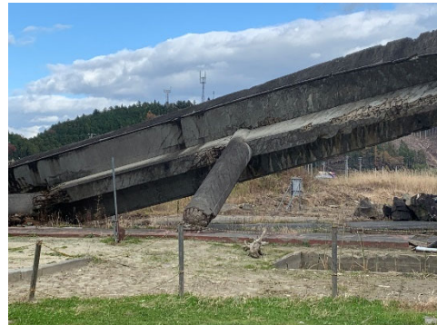
崩れ落ちた渡り廊下
